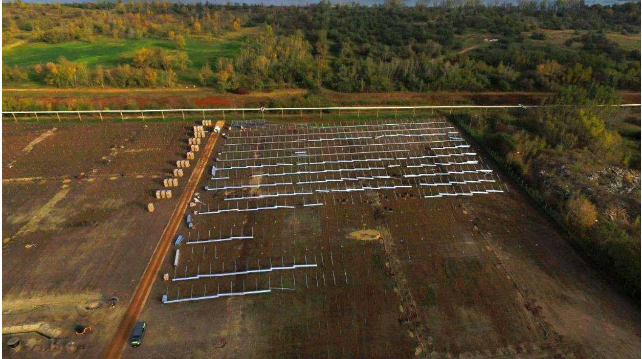
Luftaufnahme der Baustelle mit einer Drohne.
